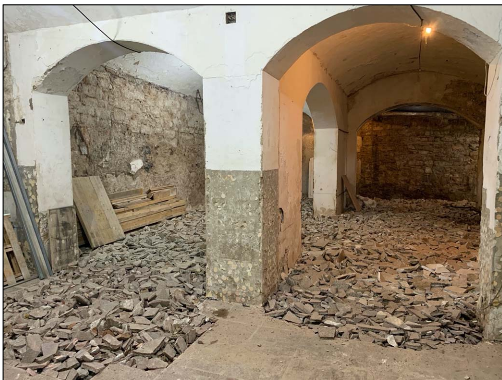
3. Estat inicial de la planta semisoterrani, extracció dels nivells de pavimentació existents (UE001).
