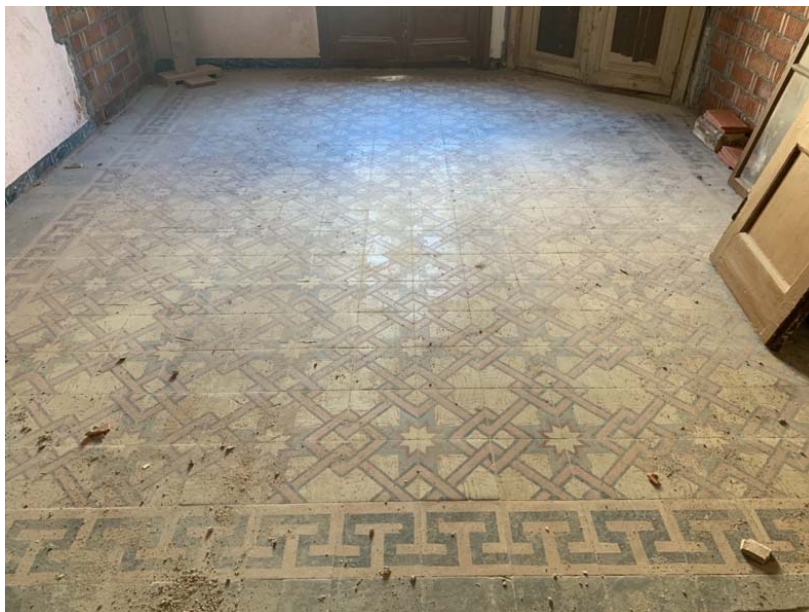
Mostra de pavimentació hidràulica present en una estança del segon pis de l'edifici.
