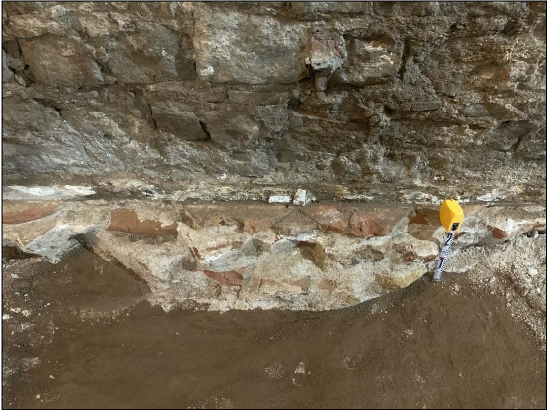
5. Detall de la pavimentació original de la planta semisoterrani.
