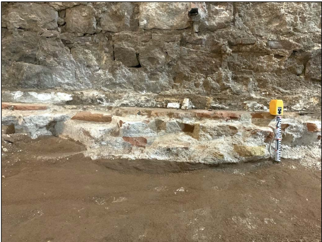
6. Detall de la pavimentació original de la planta semisoterrani.
