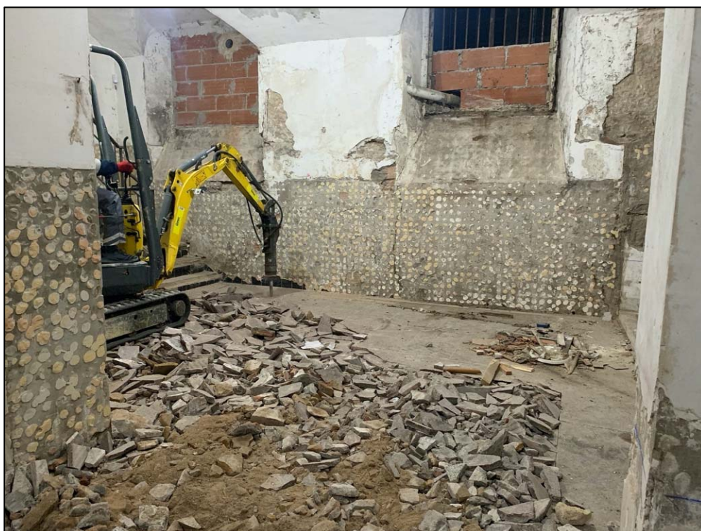
8. Màquina realitzant l'extracció de la pavimentació contemporània existent.
