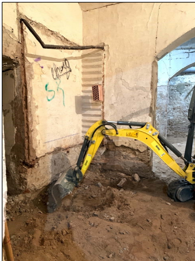
16. Màquina iniciant les tasques d'extracció de terres per al fossat de l'ascensor.
